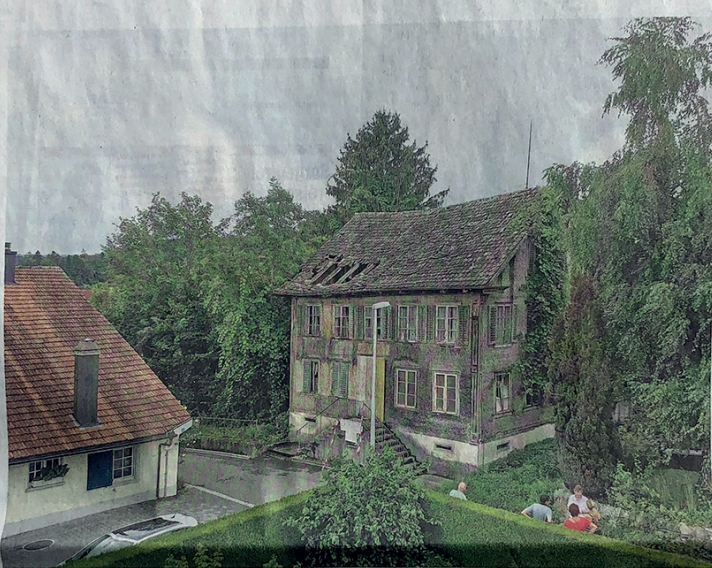
Das ehemalige Restaurant Wiesenau ist seit längerem einsturzgefährdet. Archivfoto: Conradin Krabenhans
